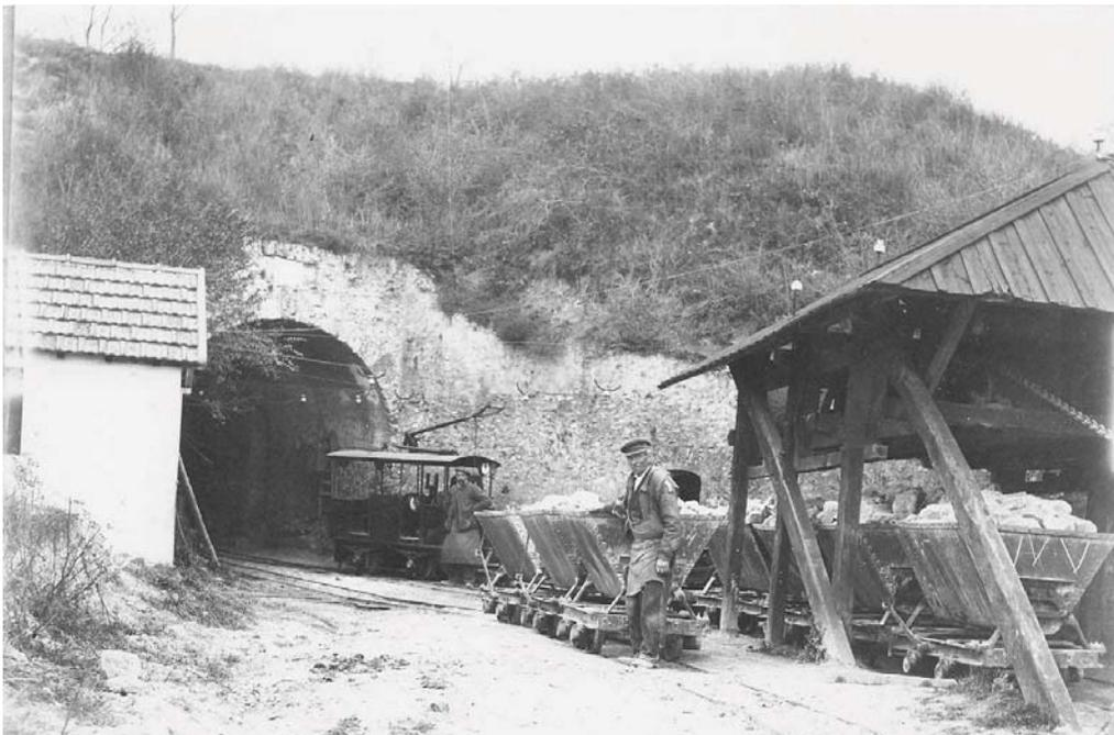
Carrière de Pissefontaine avec des wagonnets à benne basculante et une locomotive électrique
